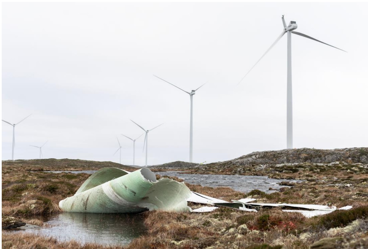
Foto: Jan Egil Eilertsen. Frøya 12.11.2021: 76 m langt rotorblad knakk og falt i bakken. Fragmenter ble spredd ut over i landskapet.
