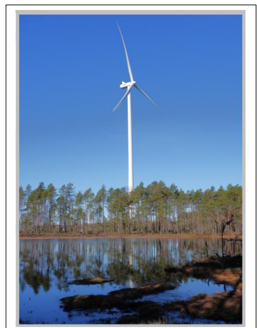
210 m-turbine i Marker vindkraftverk
