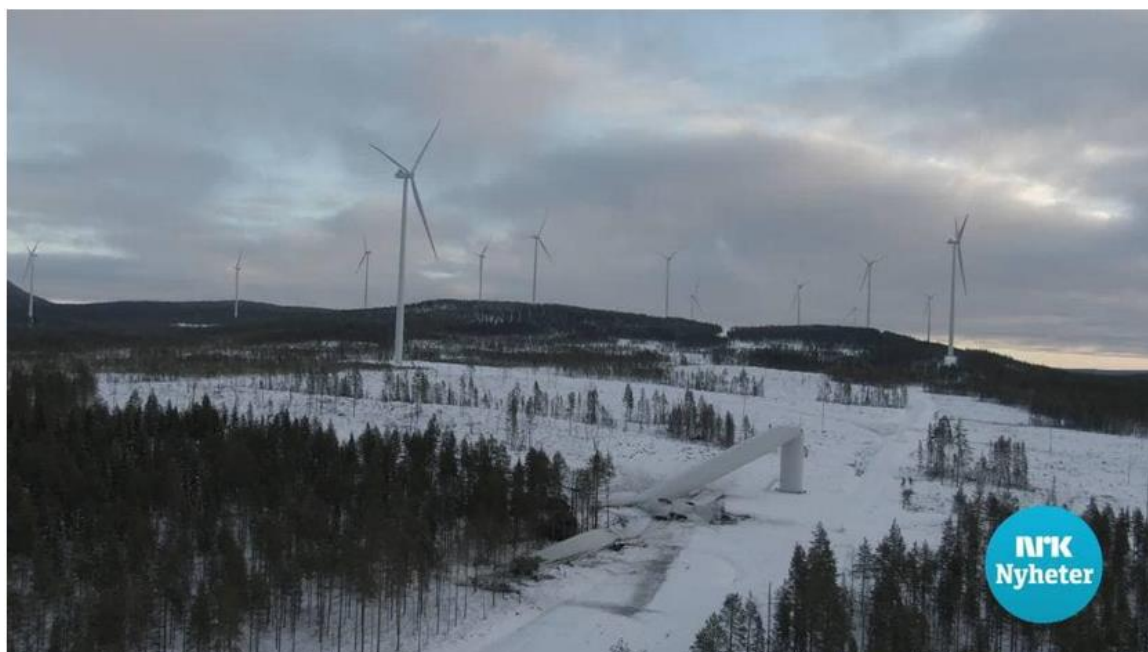
Foto: NRK. Aldemyrberget Jörn i Sverige 15. Jan 2021. Totalkollaps av det 230 m høye vindkraftverket
