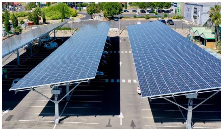
Figur 35: Eksempel på solceller som parkeringsskygge fra et anlegg i Beziers i Frankrike. Kilde: Sun'R'Power
