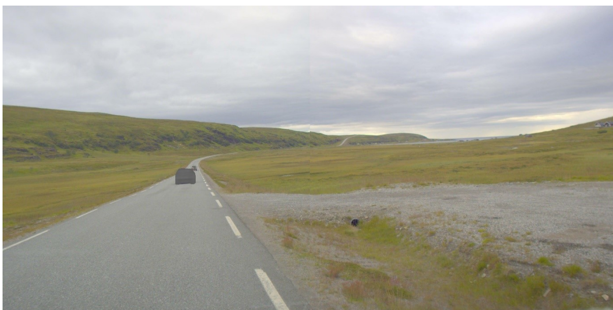
Figur 2: EV69 S6D m11228 Porsangervikelva. Krav til stoppsikt på 120 meter er oppfylt. Krysningspunkt må utbedres med rampe og markeres iht. veileder snøscooter.
