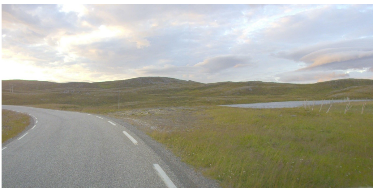
Figur 4 : EV69 S1D1 m10857 Krysningpunkt er i en innersving det kan gi problemer med sikt vinterstid med brøytekanter. Det bør ses på muligheten å flytte det.
