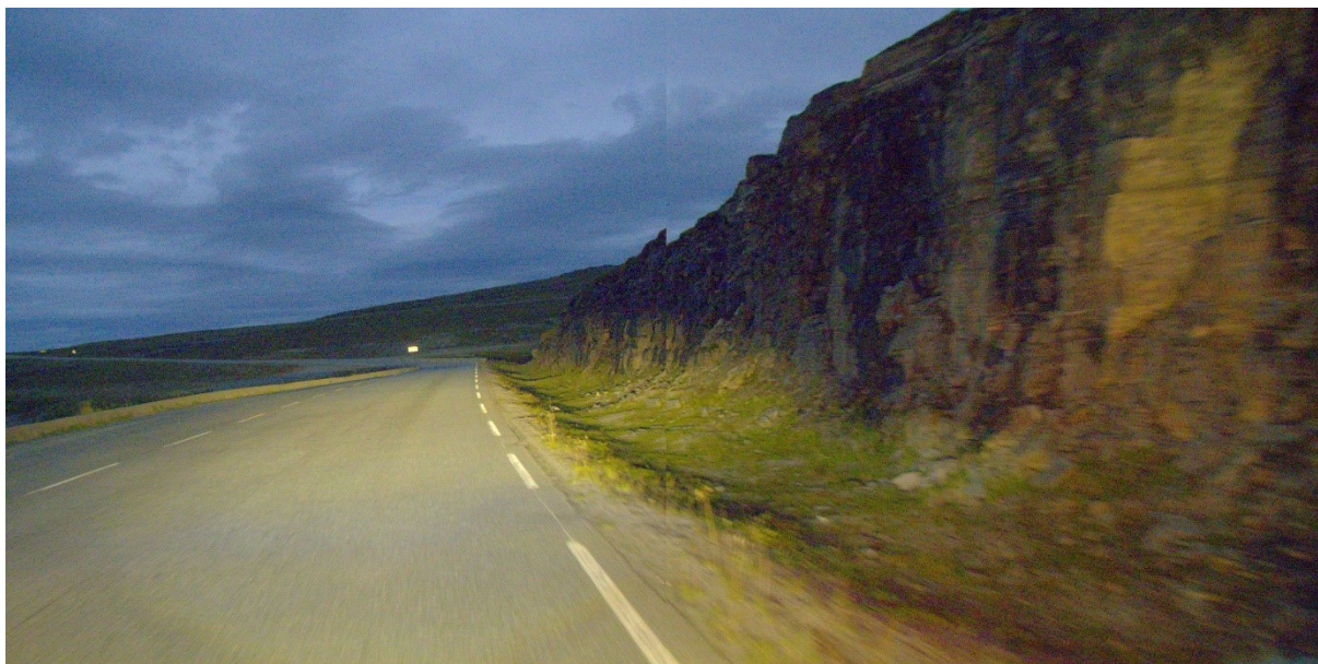
Figur 1: EV69 S6D1 m18397 Stranda. Krysningspunkt er plassert ved en fjellskjæring den bør flyttes slik at en unngår kjøring lang E6.
