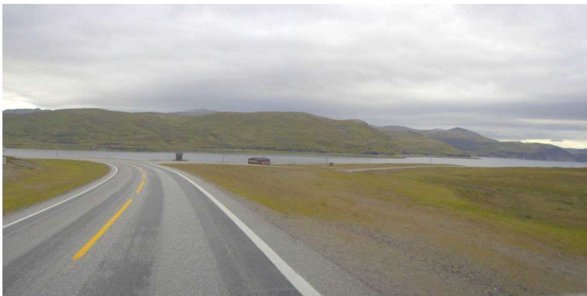
Figur 3: E69 S5D1 m 13408 Kåfjord. Krysningpunkt er i en innersving det kan gi problemer med sikt vinterstid med brøytekanter. Det bør ses på muligheten å flytte det.
