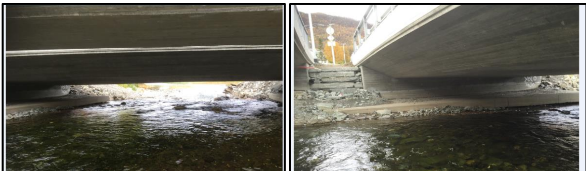
Bilde 3. Bilder av kjørebrua over Storelva. Venstre: første brua er gangbrua, mens andre brua er kjørebrua. Høyre: åpning mellom gangbrua (til venstre) og kjørebrua (til høyre).
