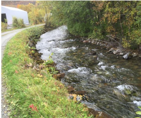
Bilde 1. Oppstrøms Storelva bru ved ca. profil 456.
