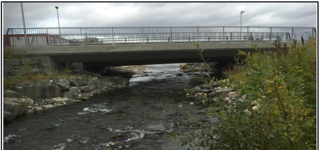
Bilde 2. Bilde av gangbrua.
