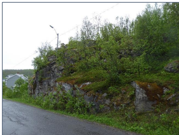
Figur 8. Parti av Klokkekarhaugen som er utsatt for steinsprang, men der ny samlevei vil medføre inngrep som sikrer mot framtidige steinsprang. Foto juni 2018: Rambøll
