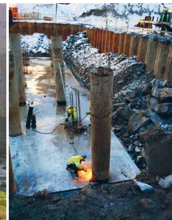
Jobbing i byggegropa for tårnfundamentet. Foto: Anne Sofie Nielsen, Statens vegvesen.
