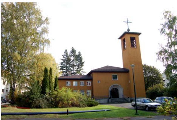
Iladalen kirke er et typisk eksempel på dårlig egnet bygg for flaggermus. Her mangler felles loftsrom, kirketårnet er åpent samt spir mangler. Foto: Leif Gjerde.
