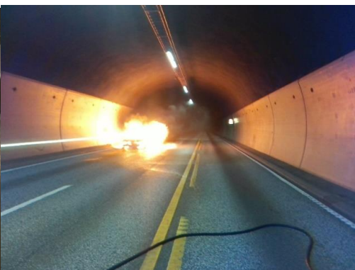
Brann i kjøretøy, Oslofjordtunnelen
