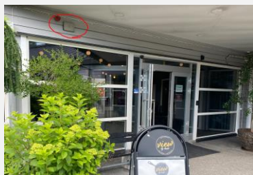
Nøkkelsafen er plassert litt vanskelig tilgjengelig over vindu
