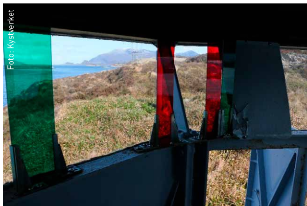
Arrangement inne i lykt. Gammel lyskilde til venstre og ny LED lyskilde til høyre.
