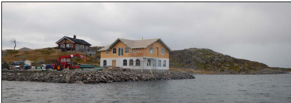
Bilde 5. Utfyllingen som er foretatt og det nye eventbygg som skal få resepsjon og restaurant. Videre bygging er satt på vent til reguleringsplanen er vedtatt og byggesøknaden behandlet på nytt.
