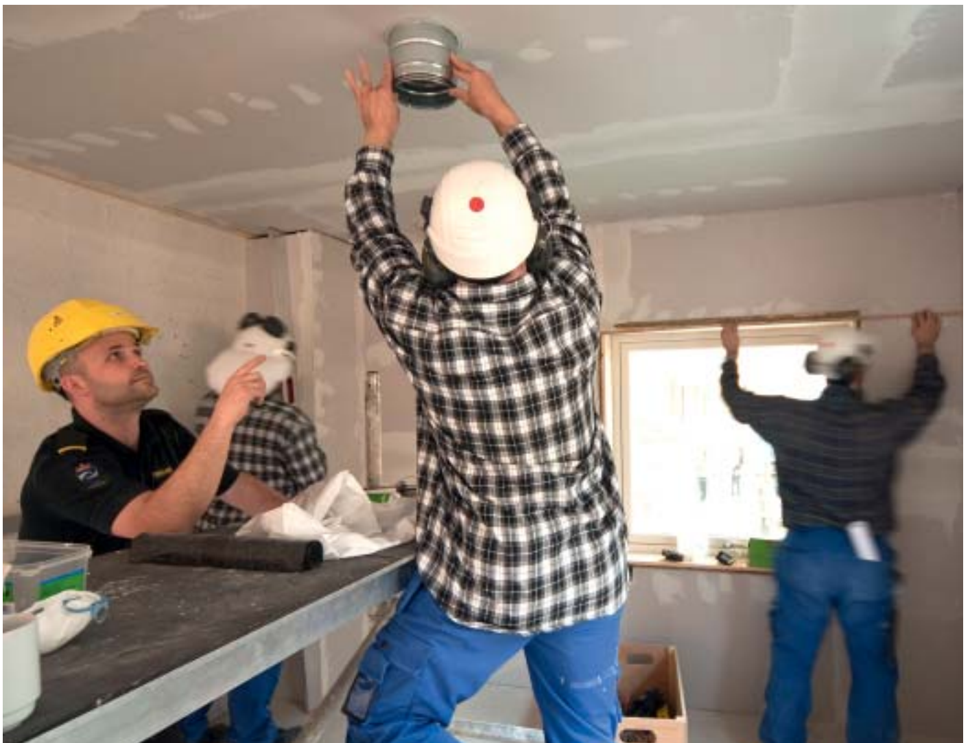
Verksbetjent Per Egil Nybruket, som selv er utdannet tømmer, følger opp det daglige arbeidet på byggeplassen.
