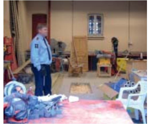
Den mekaniske verkstaden har fått plass i den tidlegare luftgården mellom dei to eldste bygga ved at del av ein vegg er reven og kjøreport satt inn.
